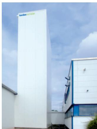
Для повышения вместимости систем устройства Shuttle XP от Kardex Remstar можно устанавливать и за пределами зданий. Доступ к складируемым товарам в этом случае будет осуществляться через специально оборудованные проемы в стенах.
